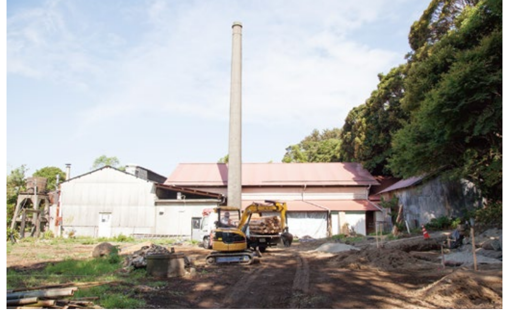
熊澤家の自宅を解体し更地にして組み立て工事がはじまりました
