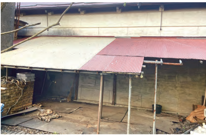
改修前の道具置場
