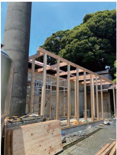
工事中の倉庫
