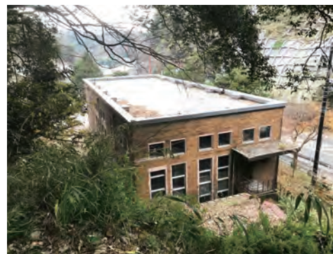
長年そのままの状態が残されていたので、はじめは廃墟のようだった。
